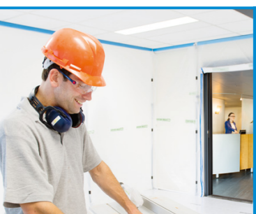
Doorwerken tijdens kantoorrenovatie
